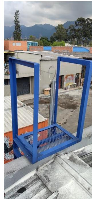
**Imagen 3. Plataforma de acceso a cubierta del Hangar**
