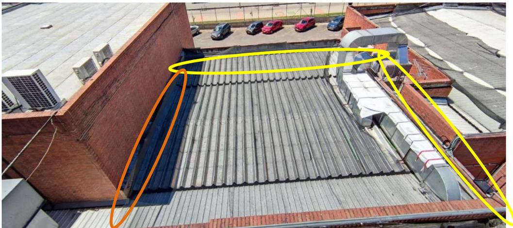
**Imagen 12. Sistemas de anclaje para desplazamientos sobre la cubierta del Estudio**
