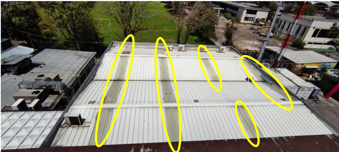
**Imagen 7. Distribución tejas traslúcidas sobre cubierta del Hangar**
