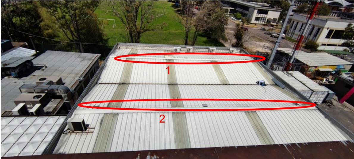
**Imagen 6. Sistemas de anclaje para desplazamientos sobre la cubierta del Hangar**
