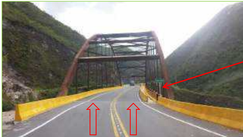
Puente Nevera, km 57.
